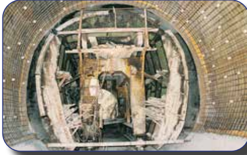
MECİDİYEKÖY - LEVENT METRO İNŞAATI / İSTANBUL - TÜRKİYE
