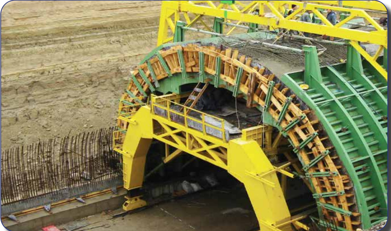
KARS - TİFLİS DEMİRYOLU • ÇELİK TÜNEL KEMER VE DIŞ KALIPLARI İMALAT VE MONTAJI KARS / TÜRKİYE
