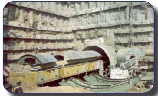
SÖĞÜTÖZÜ - ÜMİTKÖY METRO İNŞAATI ANKARA - TÜRKİYE
