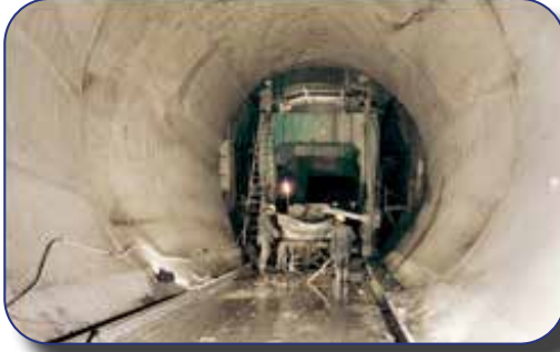
ŞANLIURFA TÜNELİ ŞANLIURFA - TÜRKİYE
