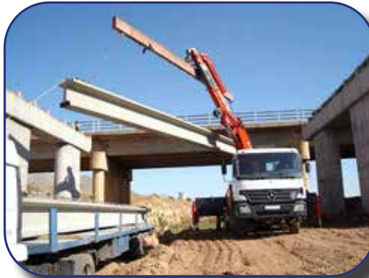
HAYDUNK KÖPRÜSÜ VİRANŞEHİR ŞANLIURFA - TÜRKİYE
