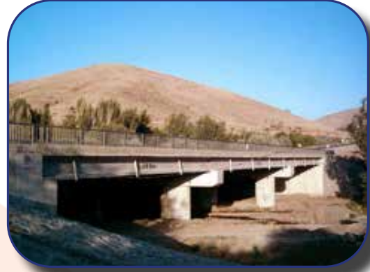
MALAGİR KÖPRÜSÜ ELAZIĞ - TÜRKİYE
