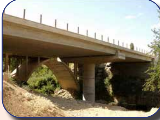
SULTAN SUYU KÖPRÜSÜ MALATYA - TÜRKİYE
