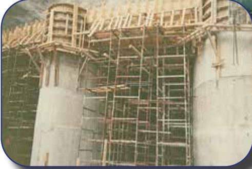
BERKE BARAJI DERİVASYON TÜNEL İNŞAATI - ADANA - TÜRKİYE
