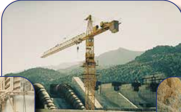
YENİCE BARAJI VE HES ESKİŞEHİR - TÜRKİYE
