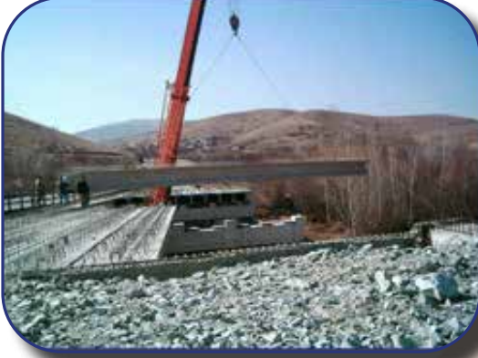
MAMIKHAN KÖPRÜSÜ BATMAN - TÜRKİYE
