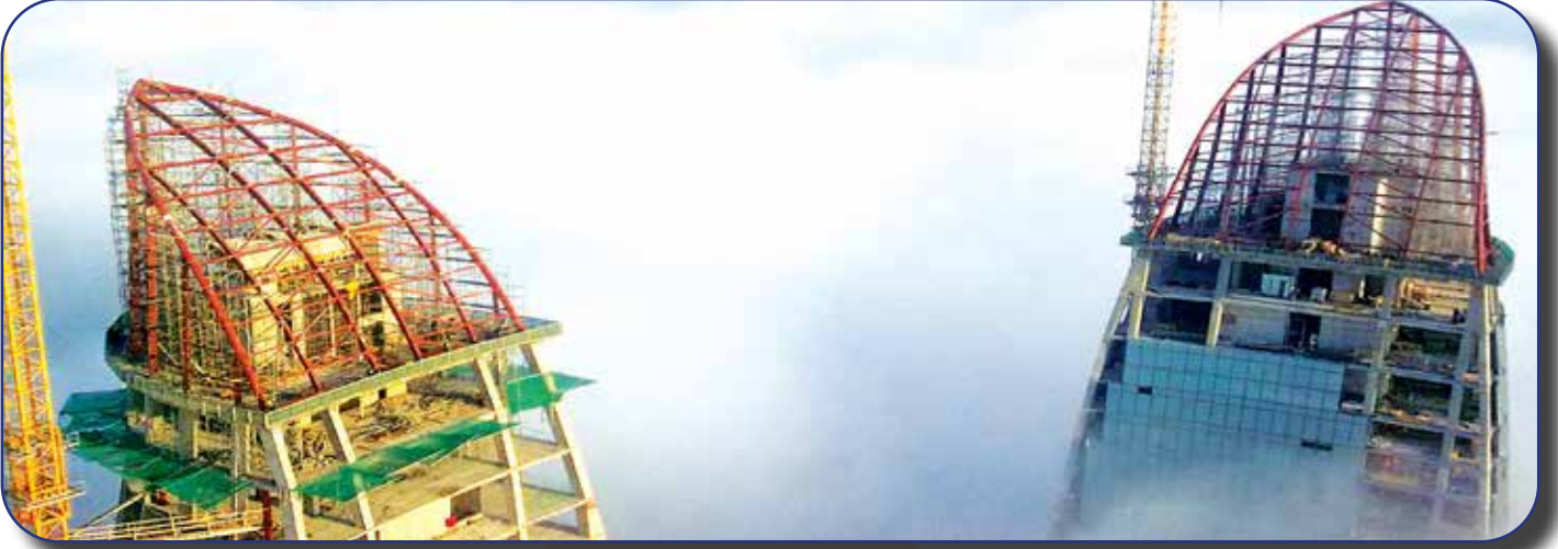
FLAME TOWER (ALEV KULESİ) • 3 ADET KULE ÜZERİ FLICK ÇELİK YAPILARI İMALAT VE MONTAJI BAKÜ / AZERBAYCAN
