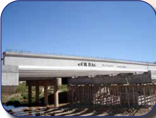
İNCİRLİ KÖPRÜSÜ VİRANŞEHİR - ŞANLIURFA - TÜRKİYE
