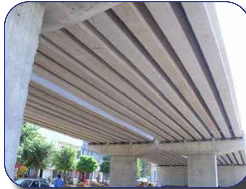
YEŞİLDİREK KÖPRÜSÜ - ŞANLIURFA - TÜRKİYE
