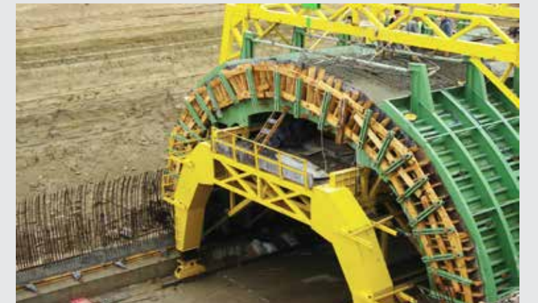
Kars - Tiflis Demiryolu Çelik Tünel Kemer ve Dış Kalıpları İmalat ve Montajı Kars/TÜRKİYE Kars - Tbilisi Railway Tunnel Arch and Outer Formworks Manufacturing and Erection Kars/TURKEY
