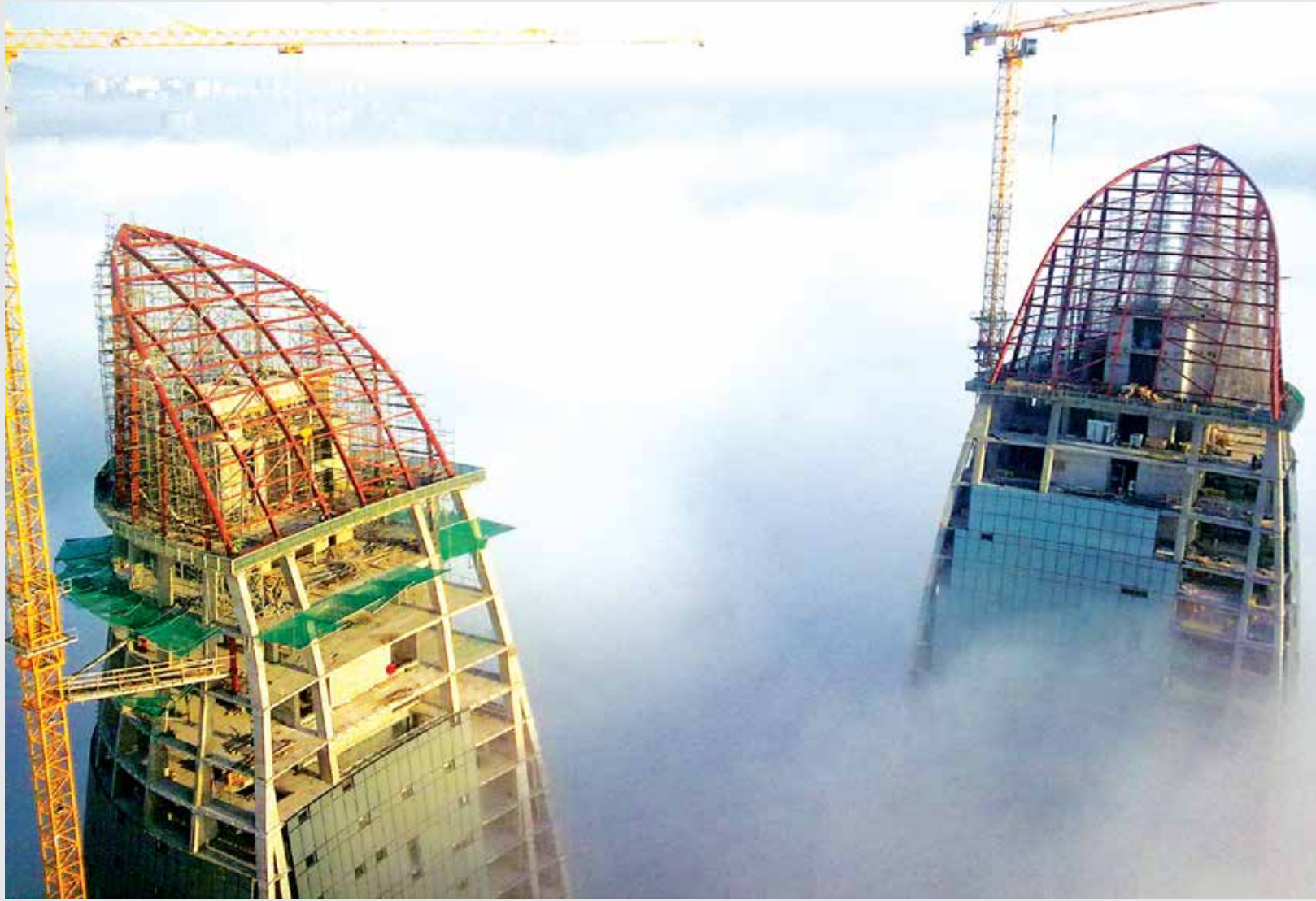
Alev Kulesi 3 Adet Kule Üzeri Çelik İmalat ve Montajı Bakü/AZERBAIJAN Flame Tower 3 Piece Flick Steel Manufacturing and Erection Baku/AZERBAIJAN
