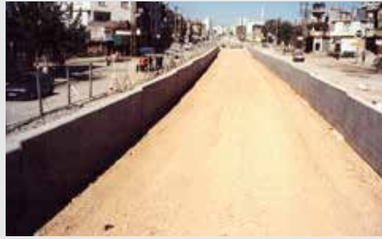
Adana Metro İnşaatı Adana/TÜRKİYE Adana Metro Project Adana/TURKEY
