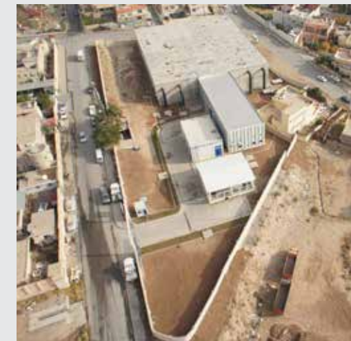
Grebasy Su Deposu / Grebasy Water Reservoir
