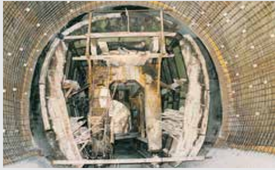
Mecidiyeköy - Levent Metro İnşaatı İstanbul/TÜRKİYE Mecidiyeköy - Levent Metro Project İstanbul/TURKEY
