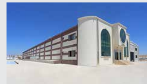
Alkoçlar Soğuk Hava Deposu Şanlıurfa/TÜRKİYE Alkoçlar Cold Storage Şanlıurfa/TURKEY
