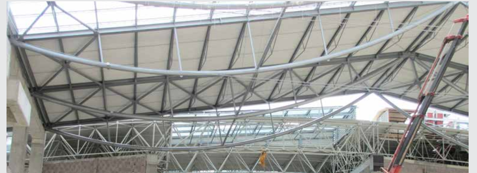
Nata Vega Alışveriş Merkezi Çelik İmalat ve Montajı Ankara/TÜRKİYE Nata Vega Shopping Center Steel Manufacturing and Erection Ankara/TURKEY
