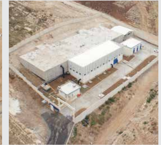
Nizari-1 Su Deposu / Nizari-1 Water Reservoir
