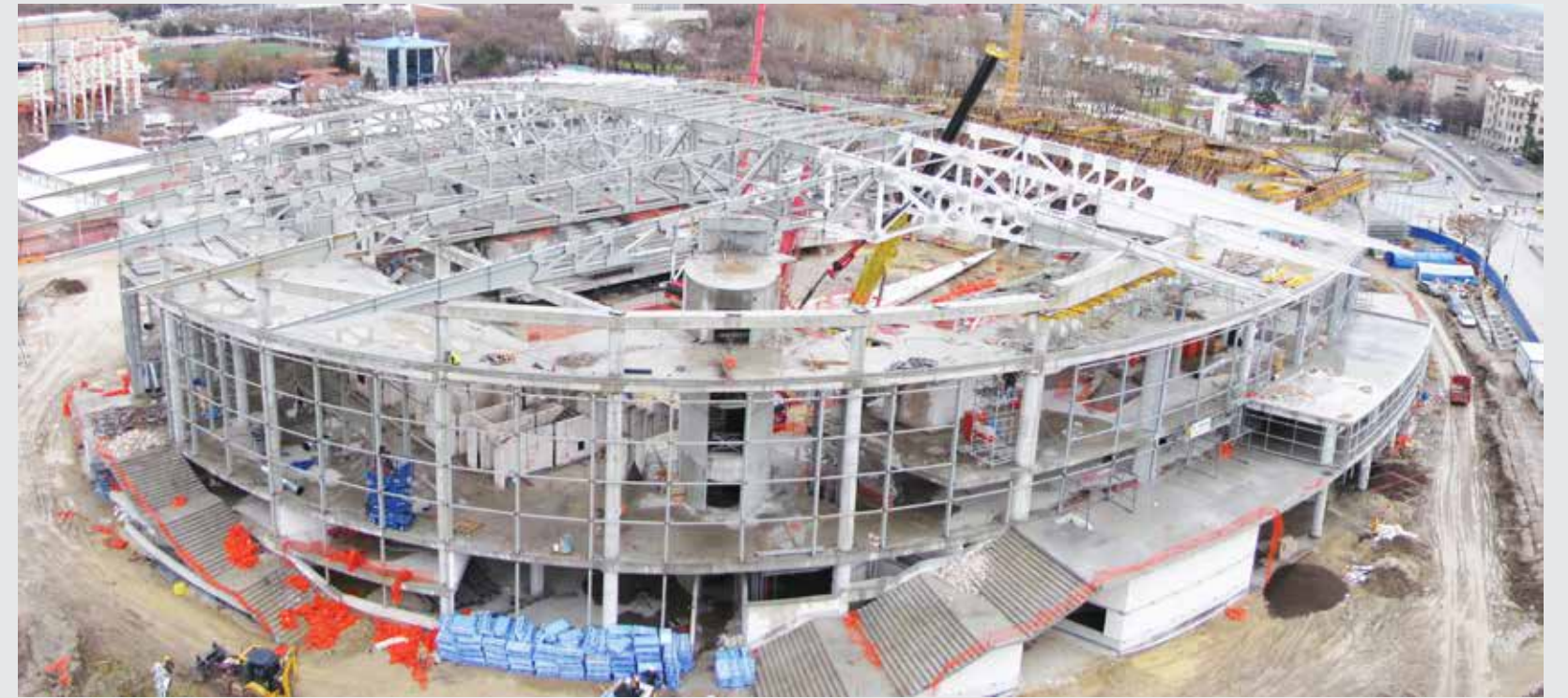
Ankara Arena Çok Amaçlı Kapalı Spor Kompleksi Çelik İmalat ve Montajı Ankara/TÜRKİYE Arena Multipurpose Sport Complex Steel Manufacturing and Erection Ankara/TURKEY
