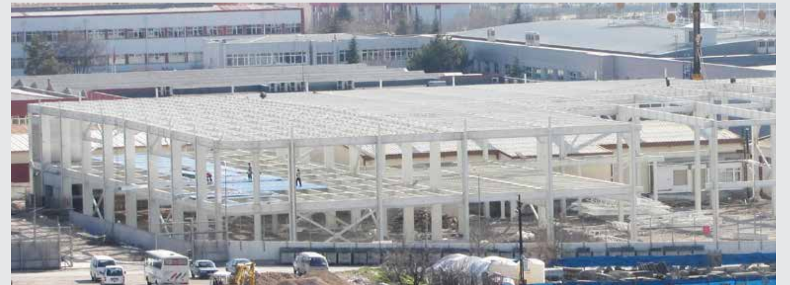
Aselsan Rehis Projesi, Ana Üretim Binası Çelik İmalat ve Montajı Aselsan Macunköy Ankara/TÜRKİYE Aselsan Rehis Project of Main Manufacturing Building, Steel Manufacturing and Erection Ankara/TURKEY
