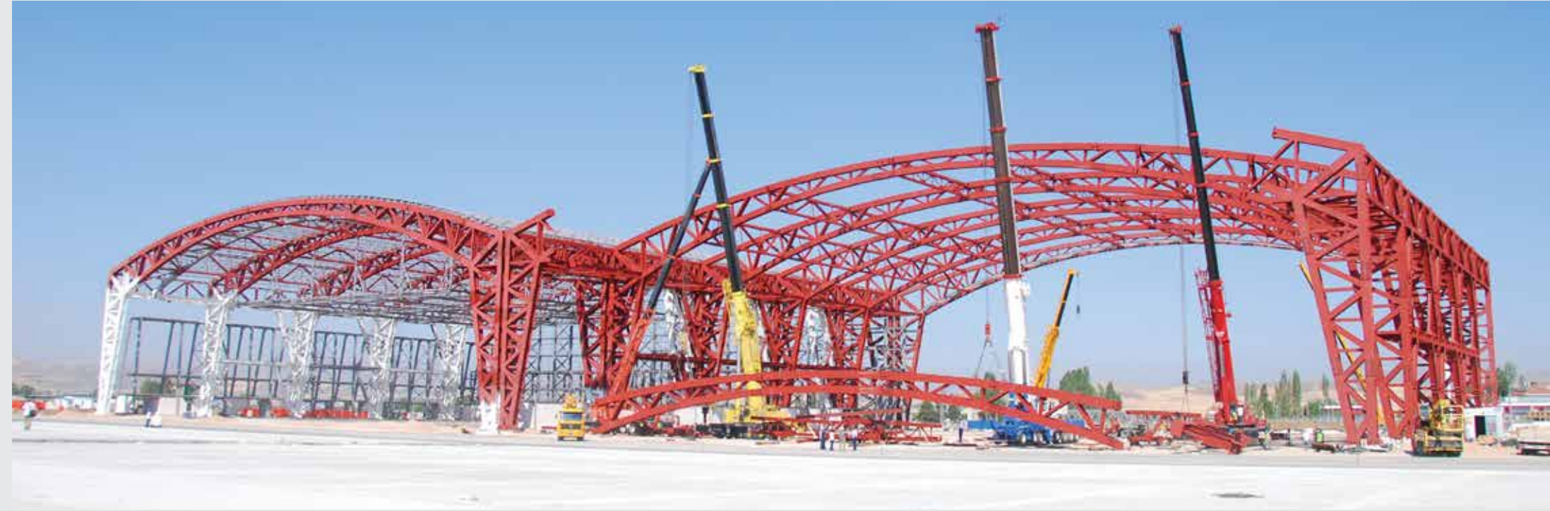
Esenboğa Havaalanı Devlet Hava Araçları Hangarı - Çelik İmalat ve Montajı Ankara/TÜRKİYE Esenboğa Airport State Aircraft Hangar - Steel Manufacturing and Erection Ankara/TURKEY
