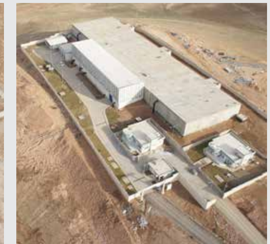
Masiek Su Deposu / Masiek Water Reservoir
