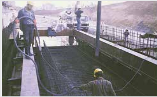
Kızılay - Batıkent Metro İnşaatı Ankara/TÜRKİYE Kızılay - Batıkent Metro Project Ankara/TURKEY
