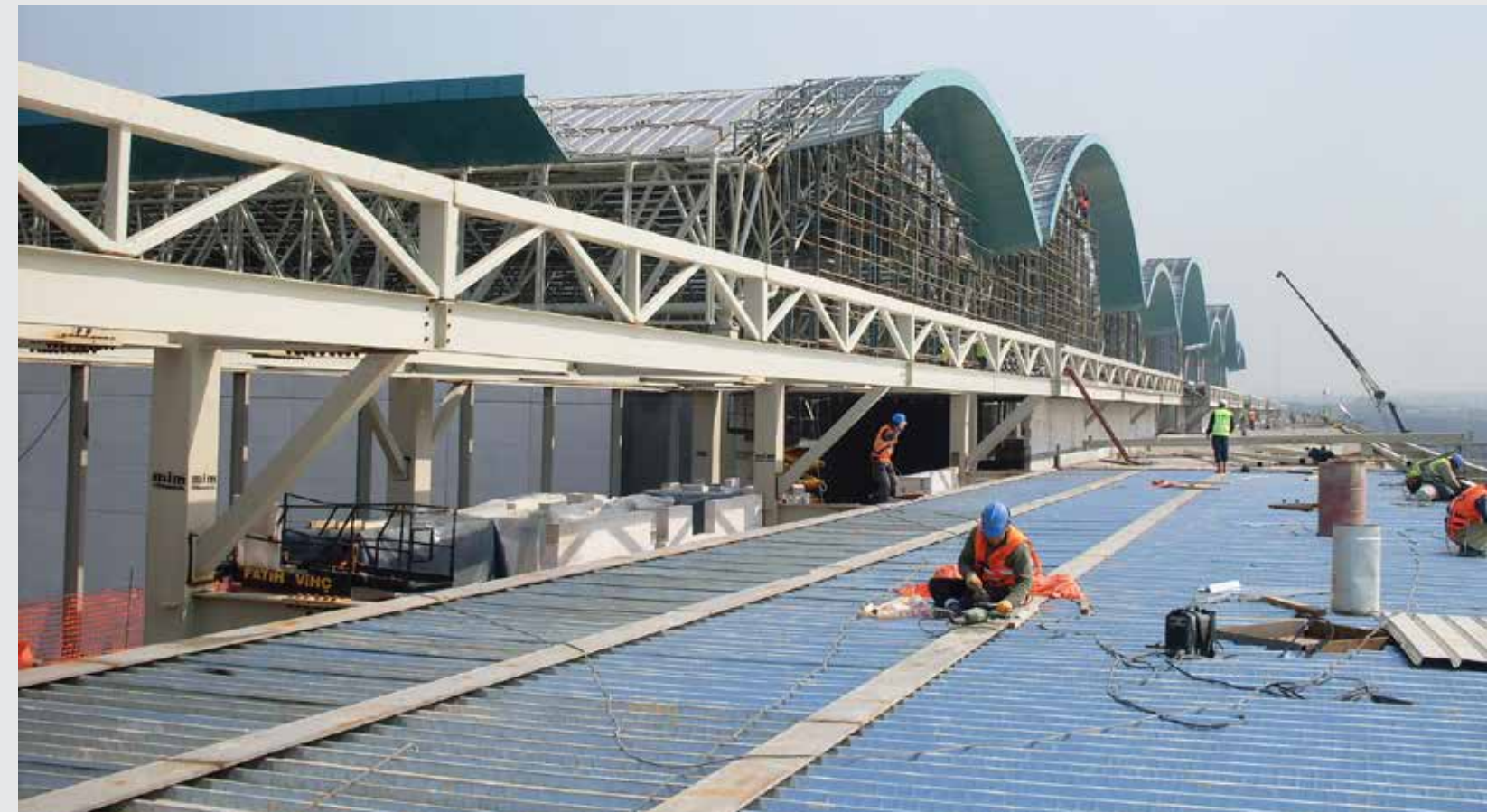
Sabiha Gökçen Havaalanı Dış Hatlar Terminali Çelik İmalat ve Montajı İstanbul/TÜRKİYE Sabiha Gökçen Airport International Terminal Steel Manufacturing and Erection İstanbul/TURKEY
