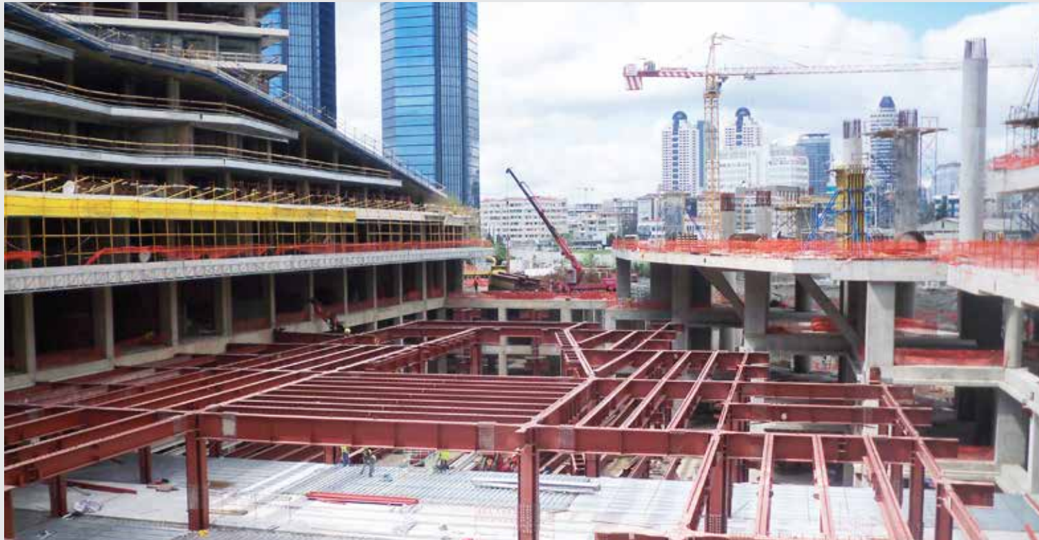
Zorlu Center Projesi, Yapısal Çelik İmalat ve Montajı İstanbul/TÜRKİYE Zorlu Center Project, Structural Steel Manufacturing and Erection İstanbul/TURKEY
