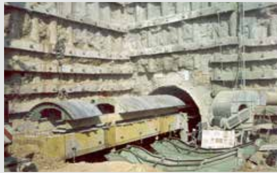
Söğütözü - Ümitköy Metro İnşaatı Ankara/TÜRKİYE Söğütözü - Ümitköy Metro Project Ankara/TURKEY
