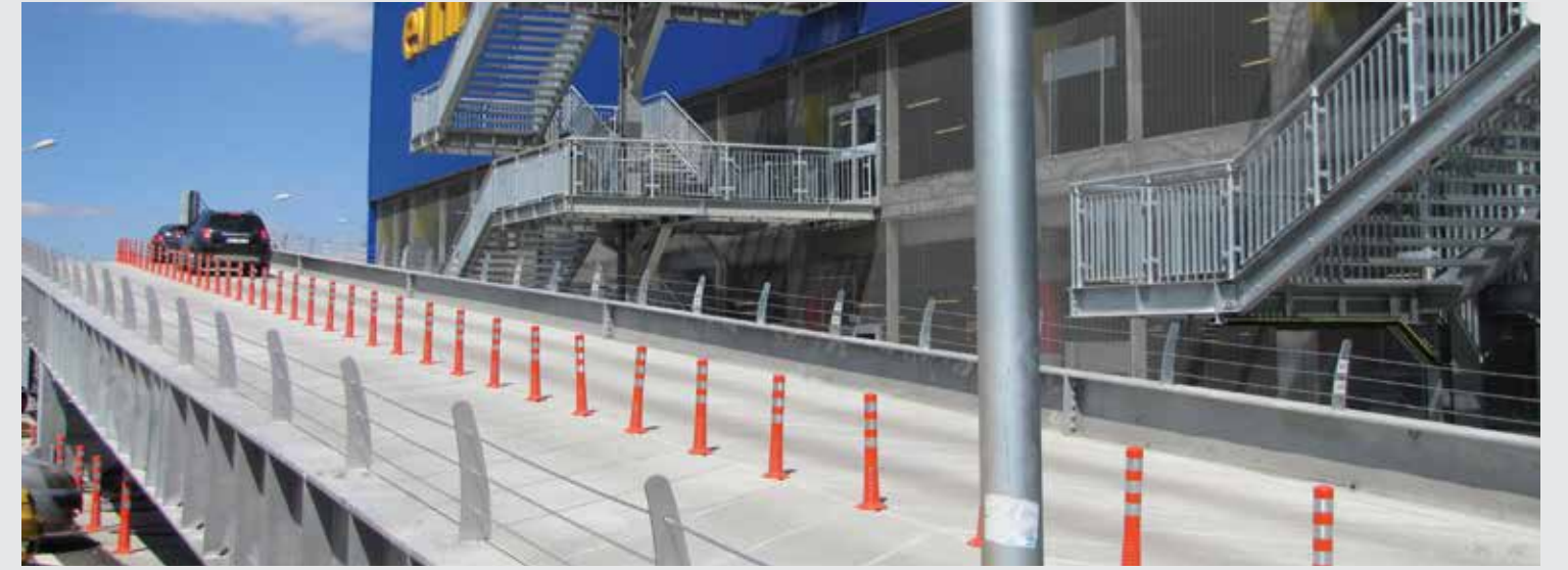
IKEA Alışveriş Merkezi Çelik İmalat ve Montajı Ankara/TÜRKİYE IKEA Shopping Center Steel Manufacturing and Erection Ankara/TURKEY
