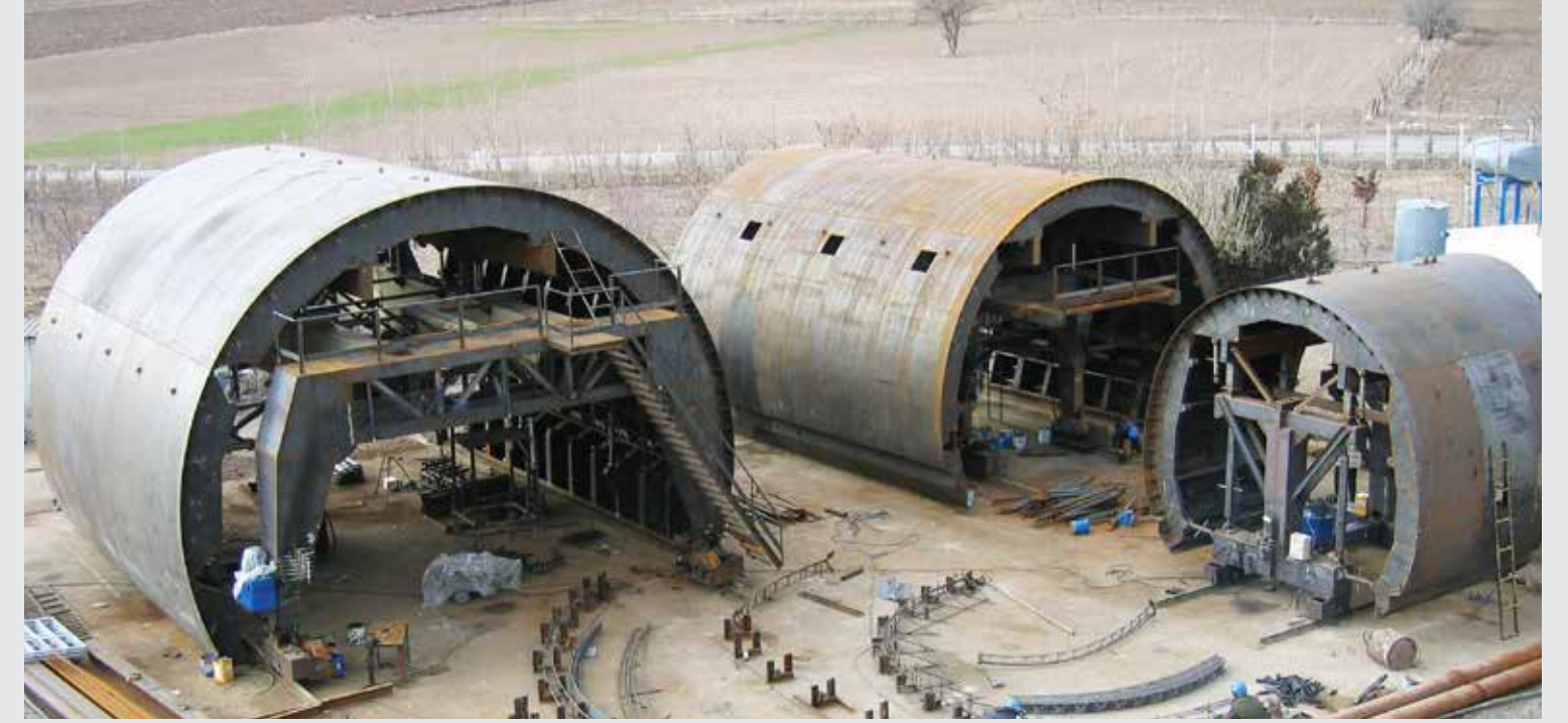
Keçiören Metrosu Çelik Tünel Kalıpları Ankara/TÜRKİYE Keçiören Subway Tunnel Formworks Ankara/TURKEY
