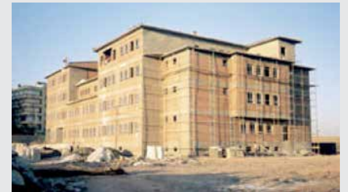
32 Sınıflı Vakıflar İlkokulu - Şanlıurfa/TÜRKİYE 32 Classroom Vakıflar Primary School - Şanlıurfa/TURKEY
