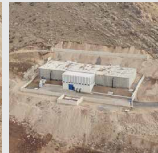
Nizari Su Deposu / Nizari Water Reservoir
