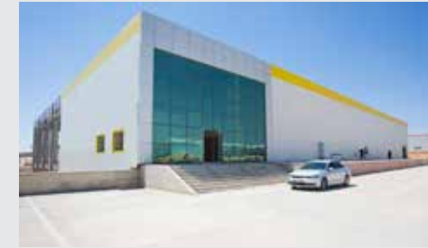
Zirve Soğuk Hava Deposu Şanlıurfa/TÜRKİYE Zirve Cold Storage Şanlıurfa/TURKEY
