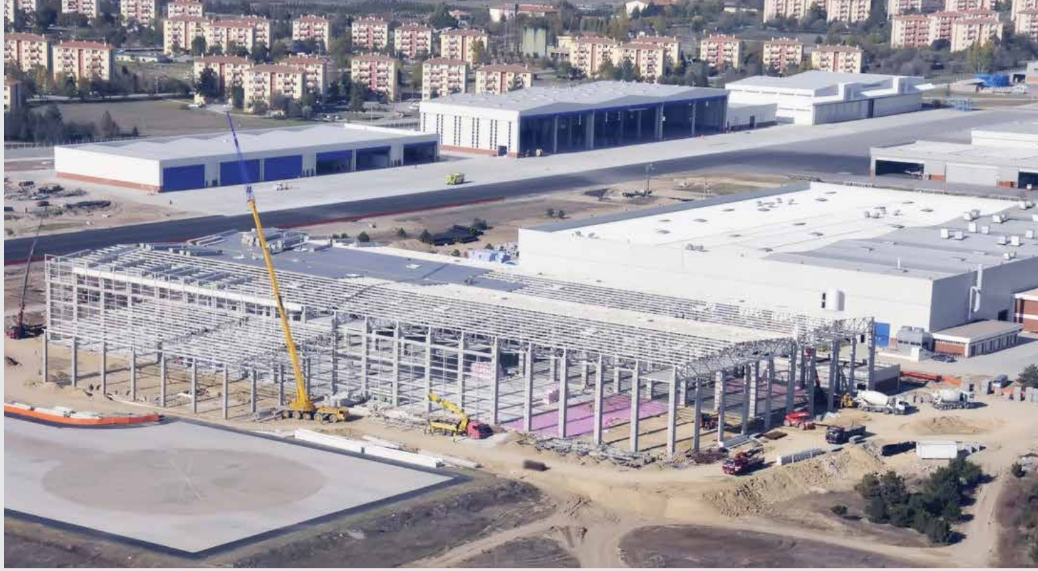
TAI 710 ve 740 Nolu Hangar Binası, Yapısal Çelik İmalat ve Montajı Ankara/TÜRKİYE TAI Building No: 710 and 740 Structural Steel Manufacturing and Erection Ankara/TURKEY
